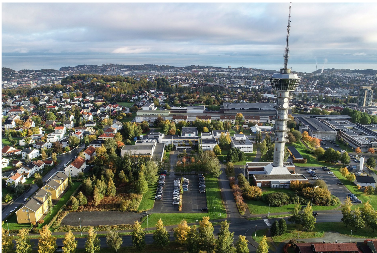
Figur 5: Foto av dagens bygningsstrukturer på NRKs eiendommer.
